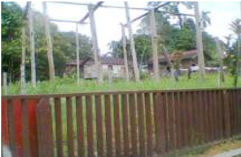
Gambar 2 : Sisa Rumah Betang Yang Rusak/ Sebelum Direnovasi
